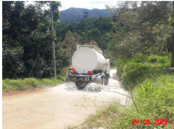
รูปที่ 6 การฉีดพรมน้ำเพื่อลดการฟุ้งกระจายของฝุ่นละออง
